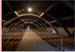
CHARPENTE // Arches et pannes en bétons armés et chevrons bois
