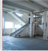
NOYAU CENTRAL // Structure béton armé
