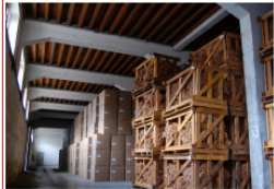
RDC // Portique poteau-poutre en béton armé et plancher bois
