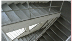
CAGE D'ESCALIER PIGNON // Structure béton armé
